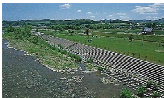
常呂川河川敷(訓子府町)
