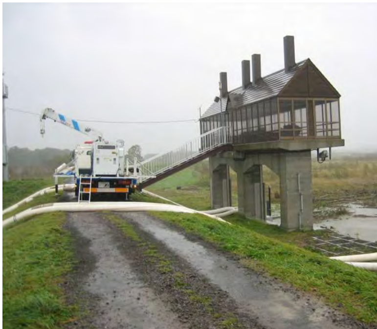
ポンプ車による内水排除の状況
