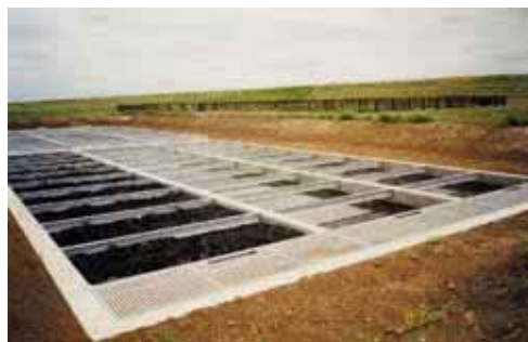
《浄化槽 黒瀬樋門》
