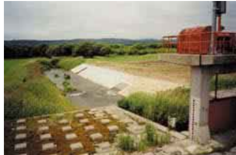
《取水放流部 黒瀬樋門》
