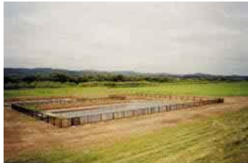
《沈砂池 黒瀬樋門》
