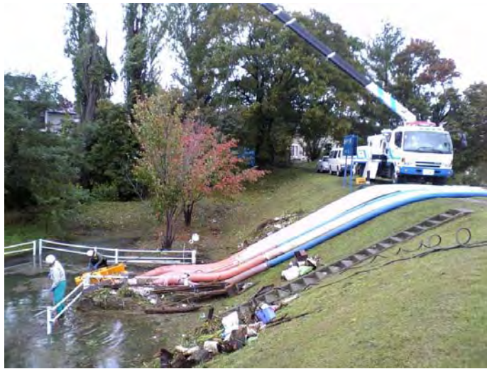
ポンプ車による内水排除の状況
