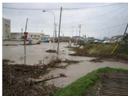
写真 4-5 平成 18 年 10 月洪水における湧別川河口部の被災状況
