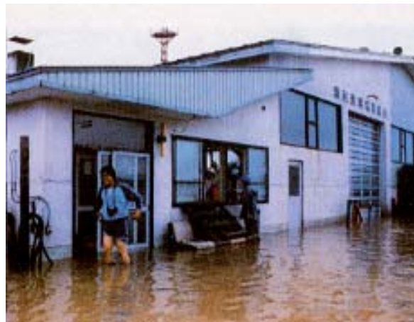
写真 4-1 昭和 56 年台風 12 号による被災状況
