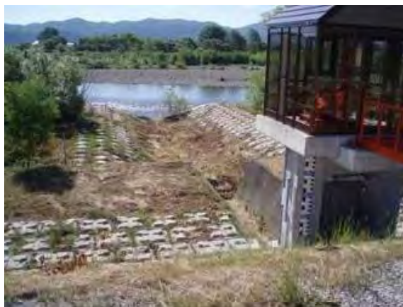
堆積土砂の発見・撤去
