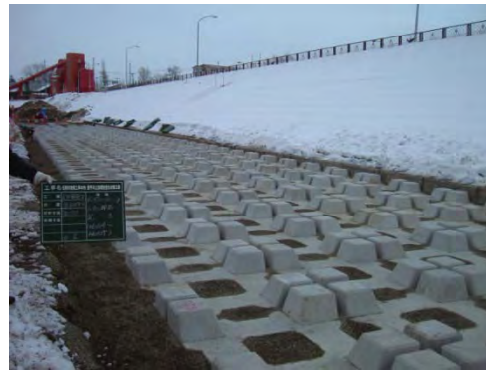
根固め工の施工例(豊平川)
