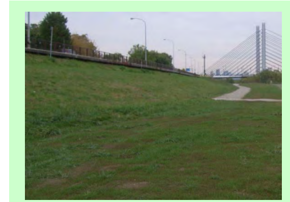
施工後の例(豊平川)
