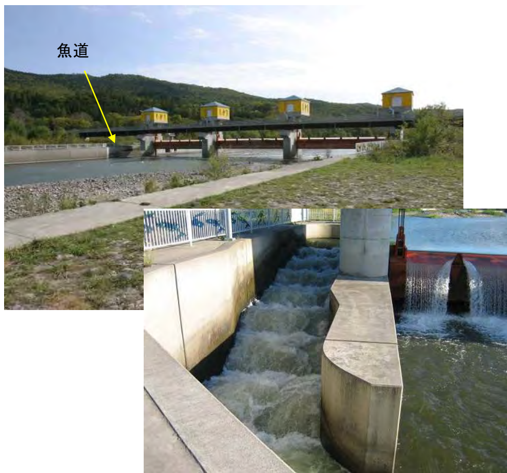
開盛頭首工および魚道
