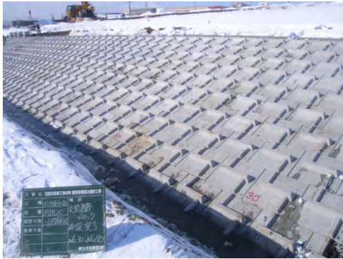
大型連接ブロック張の施工例(豊平川)
