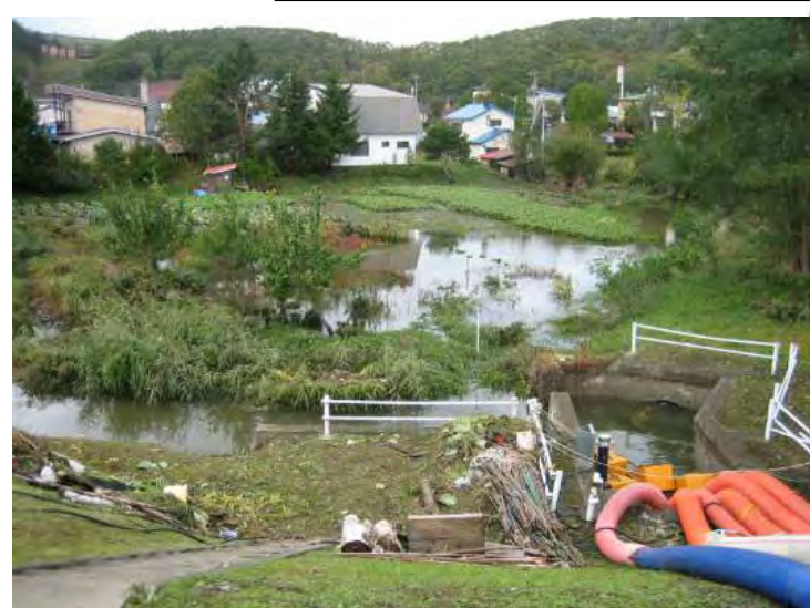
ポンプ車による内水排除の状況 (H18. 8洪水：西町樋門付近)
