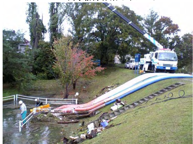
ポンプ車による内水排除の状況 (H18. 8洪水：西町樋門付近)
