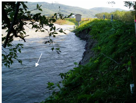
平成 18 年 10 月洪水の状況 （開盛堤防の被災状況）
