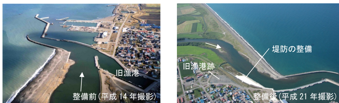
河口部の無堤区間の整備(平成 19 年完成)
