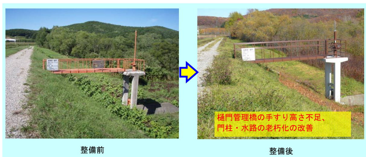
樋門管理橋の補修の例（富美第一樋門）
