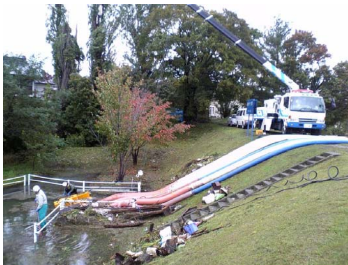
ポンプ車による内水排除の状況
