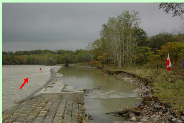
洪水により破損した護岸の補修
