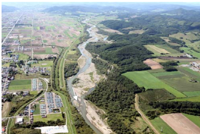
下流河道の状況 (KP8.0 付近)
