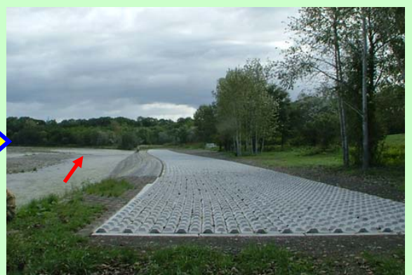
洪水により破損した護岸の補修
