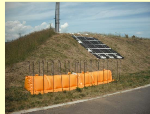
【工法展示】水マット工(左)・シート張工(右)
