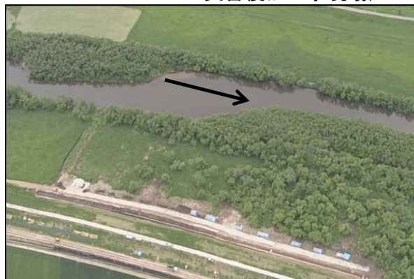
網走川KP19.6付近(H28.8出水による 災害復旧工事現場)
