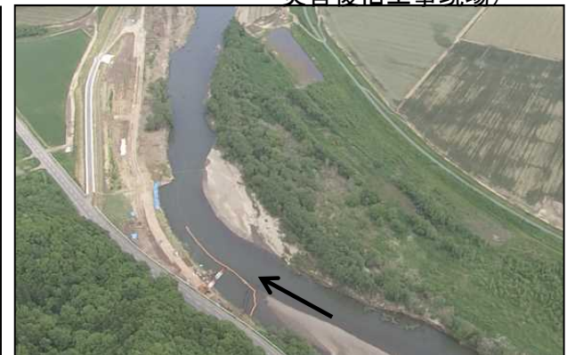
常呂川KP22付近(H28.8出水による 災害復旧工事現場)
