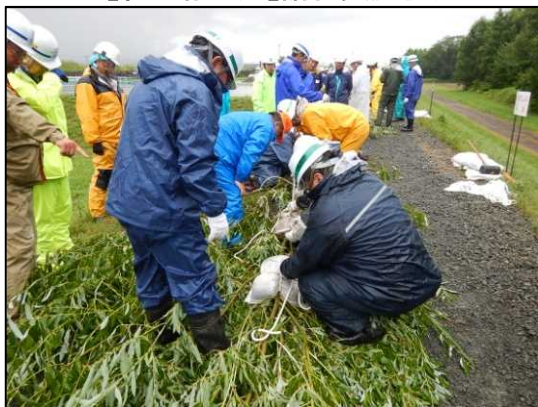
【木流し工法】講習実施状況
