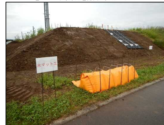
【工法展示】水マット工・シート張工
