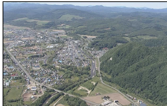
無加川留辺薬市街付近(北海道管理区間)
