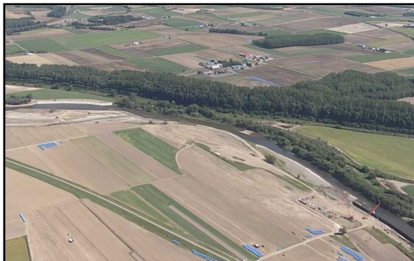
常呂川KP40付近(H28.8出水による 災害復旧工事現場)
