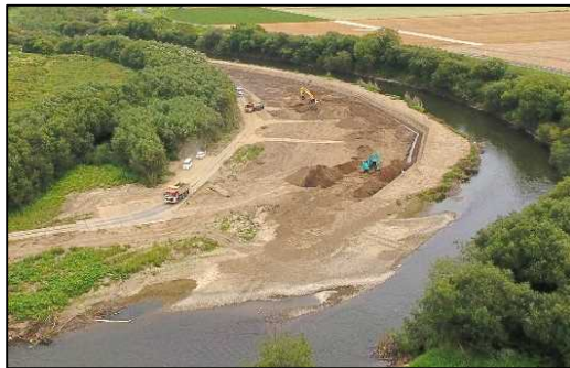
主な災害復旧工事(河道掘削)
