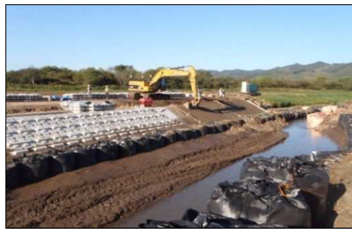
主な災害復旧工事(低水護岸)
