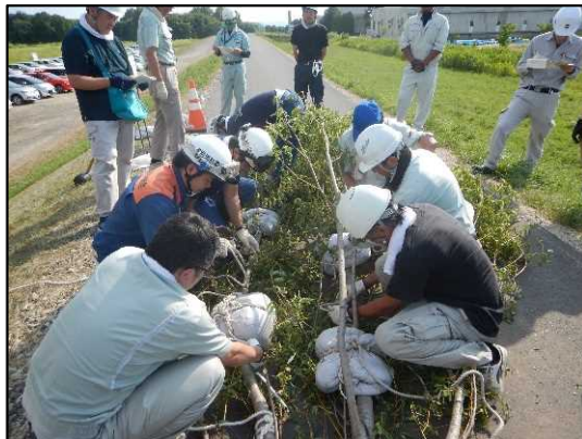
【木流し工法】実施状況
