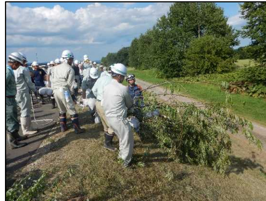
【木流し工法】実施状況
