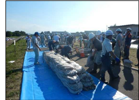
【積土のう工】実施状況
