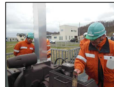
《樋門の操作状況》
