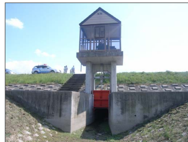
《樋門です … 雨水などを堤防の中を通して河川に流すために堤防に設置される施設》
