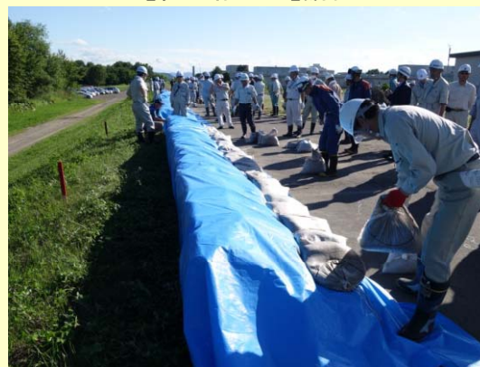
【積土のう工】講習実施状況
