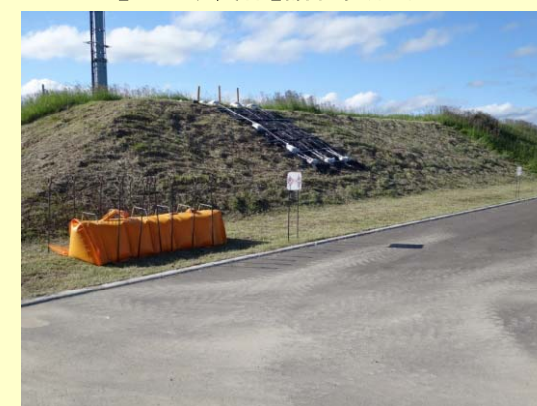
【工法展示】水マット工・シート張工
