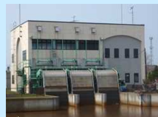
排水能力の不足(斜里右岸排水機場)
