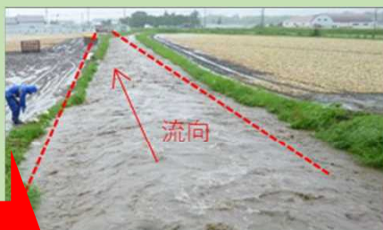
紅葉川幹線排水路溢水状況 (H28)
