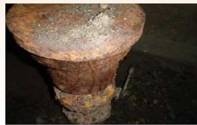
空気弁の発錆 (仁頃送水1号幹線用水路)
