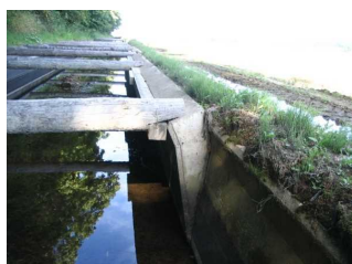
側壁の傾倒状況 (切梁により対応)
