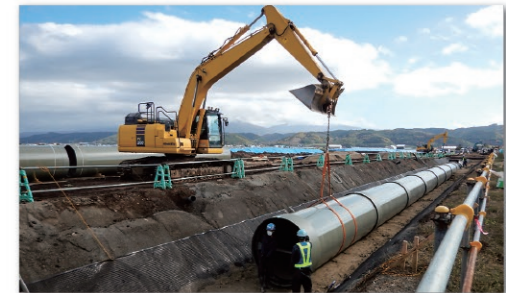
用水路工事写真 (国営施設応急対策事業 鳥沼宇文地区)
