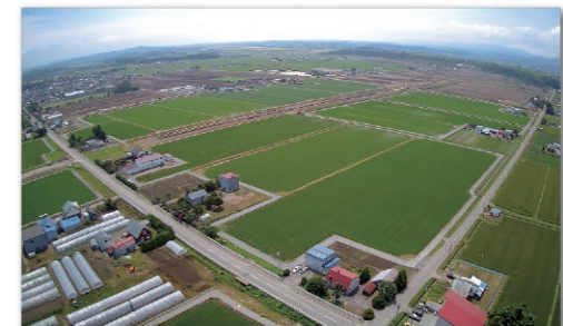
区画整理工事 整備後 (国営緊急農地再編整備事業 旭東東神楽地区)
