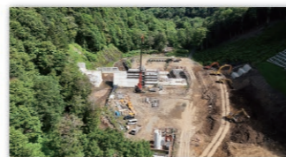
白川第2号砂防堰堤 整備状況(上川町)
