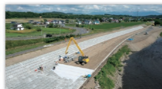
辺別川 高水敷保護工整備状況(旭川市)
