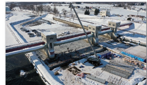
頭首工事写真 (国営かんがい排水事業 共栄近文二期地区)
