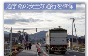
通学路の安全な通行を確保 和寒歩道整備（国道40号 和寒町）
