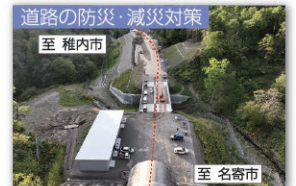
国道40号 音威子府バイパス（音中道路）
