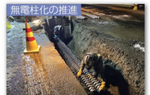
電線共同溝整備（国道38号 富良野市）
