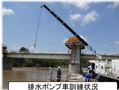
排水ポンプ車訓練状況
