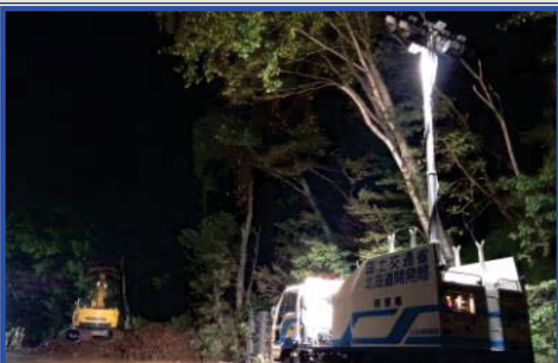
H26.9 一般国道453号 大雨に伴う土砂撤去作業による出動(千歳市)
