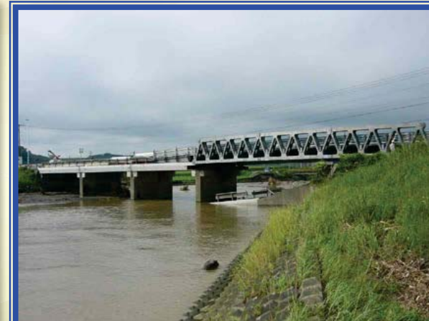
H15 一般国道235号門別町慶能舞橋架設状況
