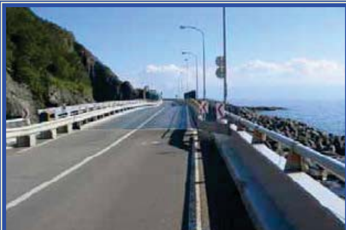
H16 一般国道229号神恵内村大森大橋架設状況
