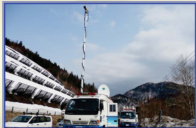
H25.4 一般国道230号 大雨による地盤変状による出動(札幌市)
