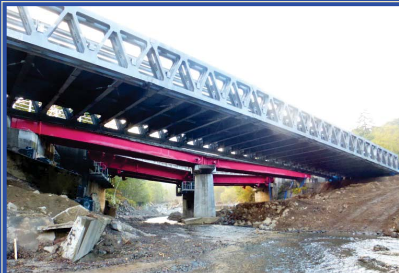
H26 一般国道453号札幌市奥魚川橋架設状況
