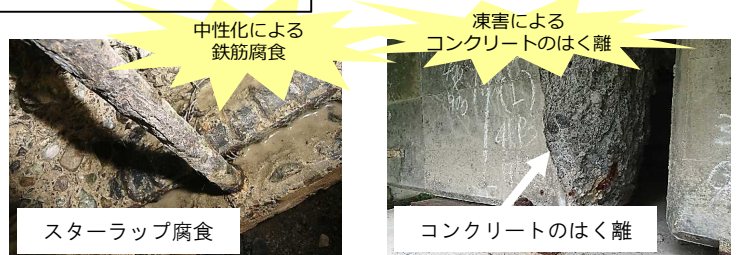
現橋の主な損傷状況
