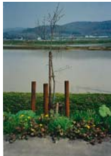
写真：雪圧防止杭3本設置した事例
