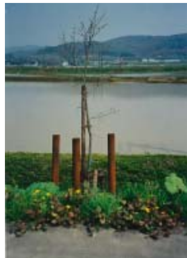
写真：雪圧防止杭3本設置した事例
