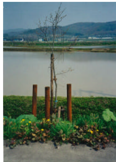
写真：雪圧防止杭3本設置した事例
