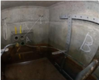
マンホール内写真
