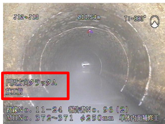
TVカメラによる管内の詳細調査
