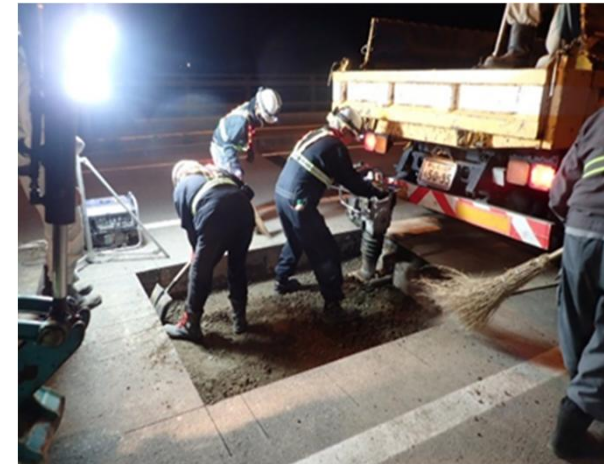
補修状況：国道12号（札幌市）
