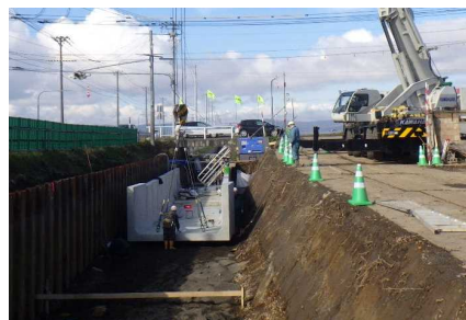
用水路の改修
