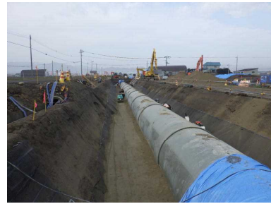
用水施設補修の長寿命化
