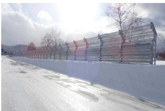
防雪対策(防雪柵)(国道275号 幌加内町)
