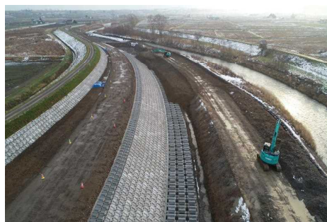
辺別川 護岸整備状況（旭川市）
