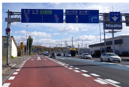
車線の明確化及び注意喚起路面標示による事故対策
