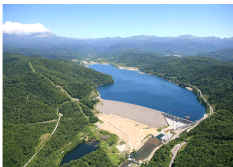
忠別ダム（東川町・東神楽町・美瑛町）
