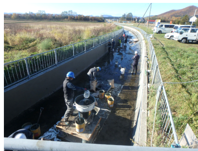
用水路の補修
