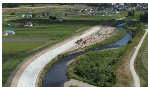
辺別川 護岸整備状況（旭川市）
