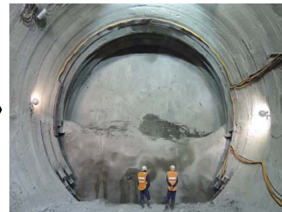
【地山改良区間の施工完了】 ①～⑤を繰り返す
