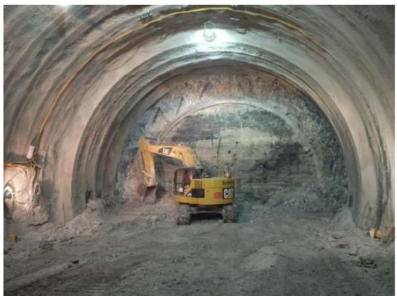
④トンネル掘削状況 〔トンネル上半部分の掘削部〕
