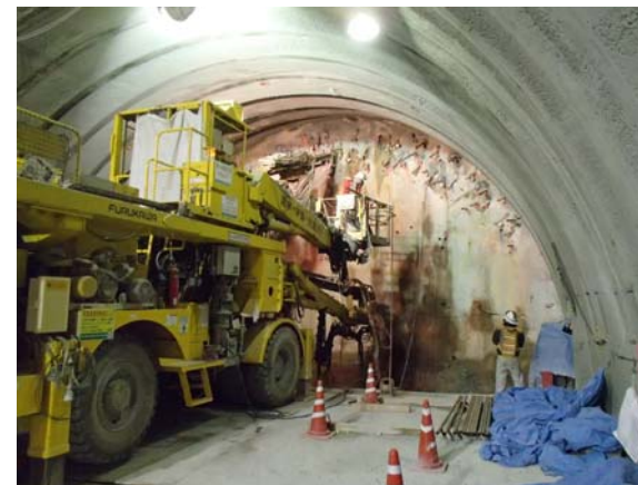
③トンネル上部の地山改良施工状況 〔地山へセメントミルクを注入〕
