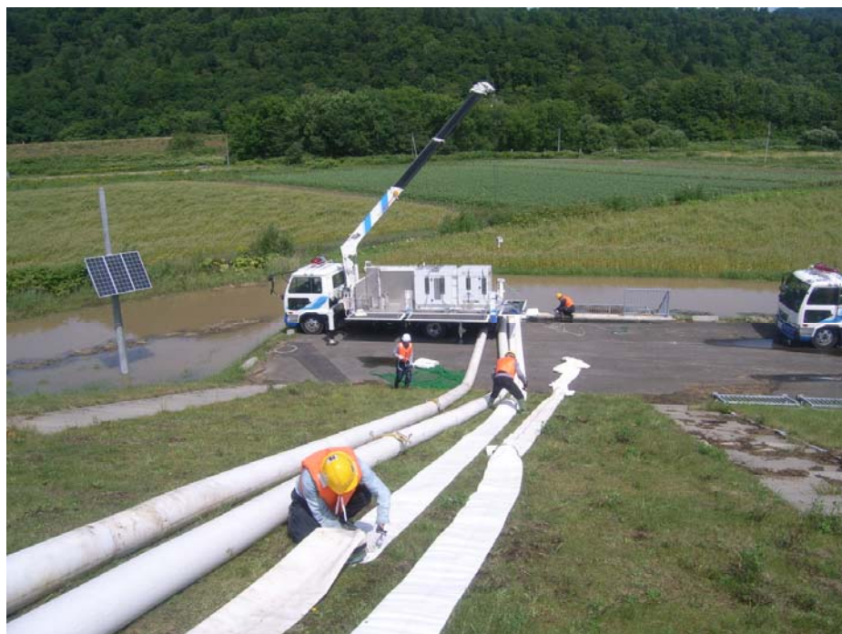
音威子府村での排水ポンプ車作業状況
