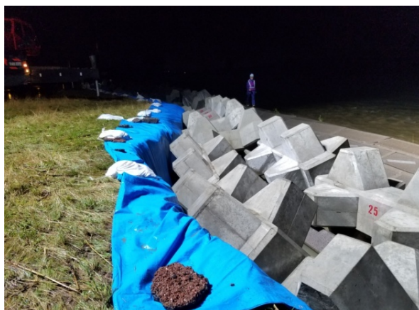
石狩川常盤地区の応急復旧完了の状況
