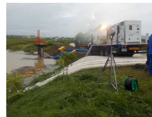
タヨロマ川での排水ポンプ車による排水作業状況
