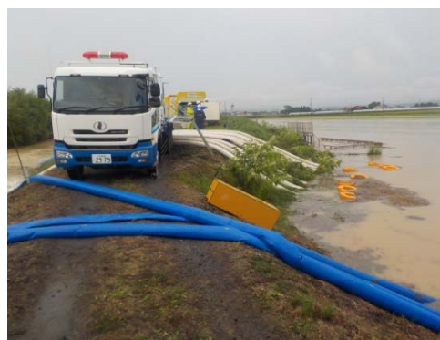
タヨロマ川での排水ポンプ車による排水作業状況
