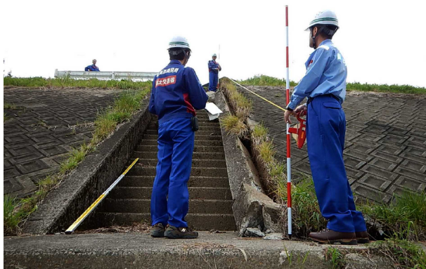
河川堤防の被害調査状況
