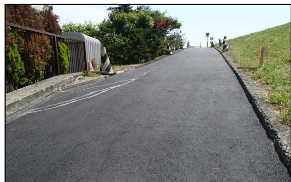
(写真①: 補修後)
