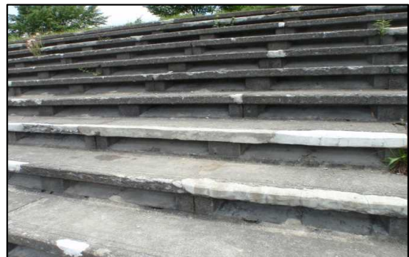
(写真④:補修後)
