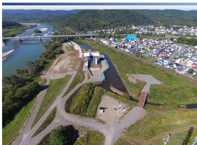
工事現場の全景
