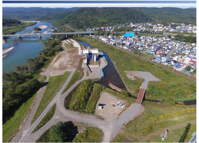
工事現場の全景
