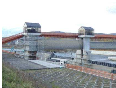
頭首工の改修
