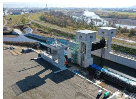
石狩川 ウップツ川水門整備状況 (旭川市)
