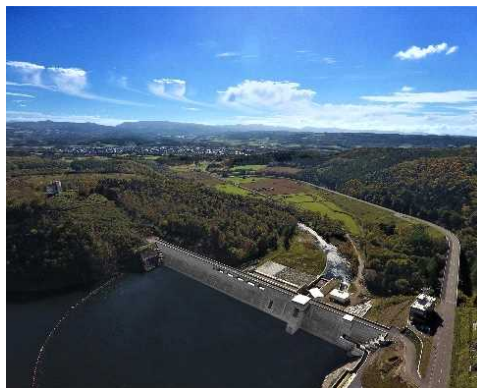
サンルダム堤体から下川町を望む (下川町)
