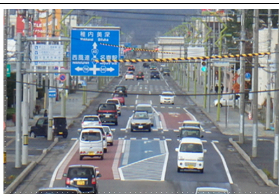
車線の明確化(カラー舗装)による交差点での追突事故防止対策
