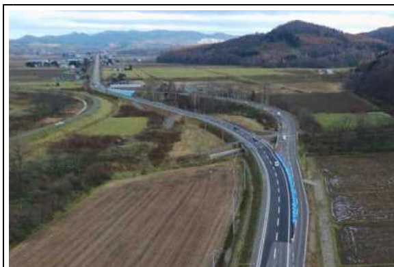
視距改良による曲線部での車線逸脱事故防止対策
