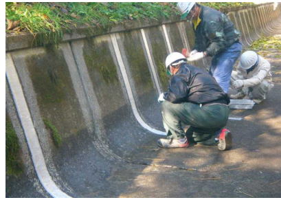
用水路補修等の長寿命化対策
