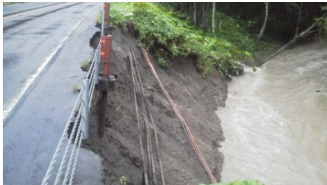
R39法面崩壊発生状況 (L=16m,H=3m,W=5m)
