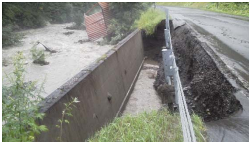
R273路肩洗掘発生状況 (L=20m,H=6m,W=5m)
