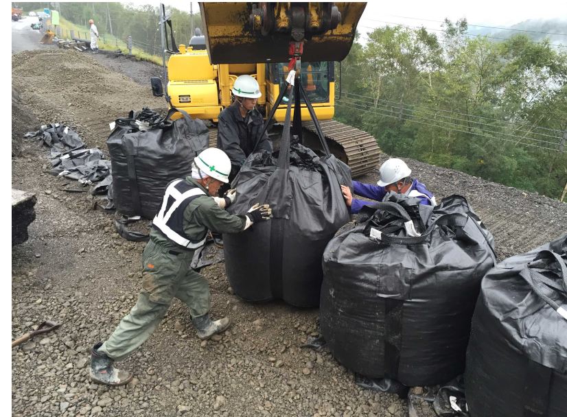
復旧状況【昼間】 ～大型土のう設置
