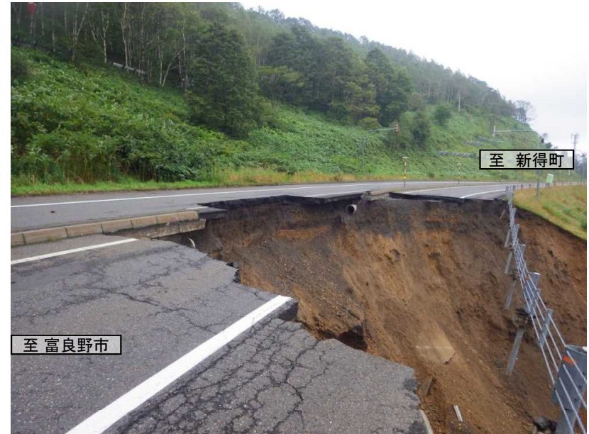
被災状況【富良野側から】 ～半断面崩落～
