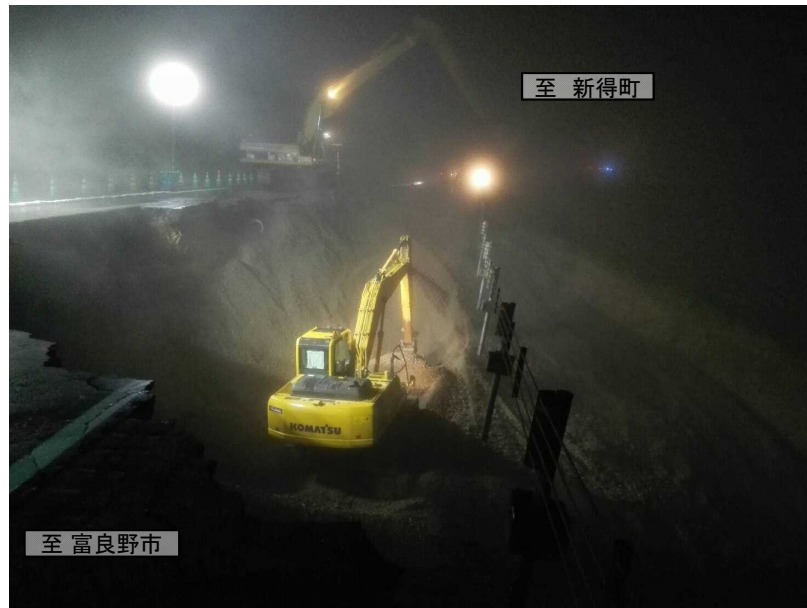
復旧状況【夜間】 ～碎石盛土～
