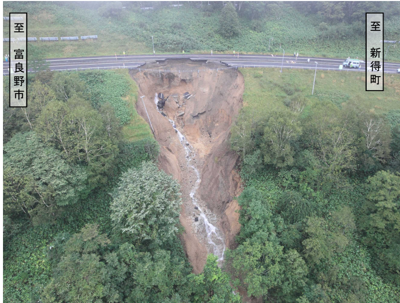
被災状況【全景】 ～半断面崩落～
