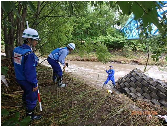
【札幌②】現地被災状況調査（美瑛町）
