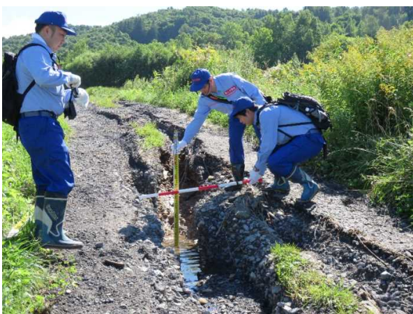
【稚内】 現地被災状況調査（剣淵町）
