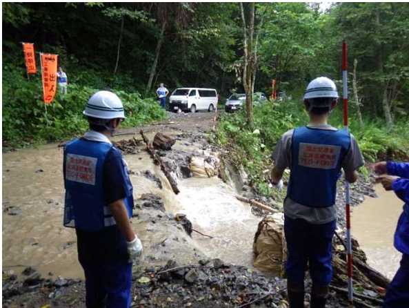
【函館】現地被災状況調査（占冠村）
