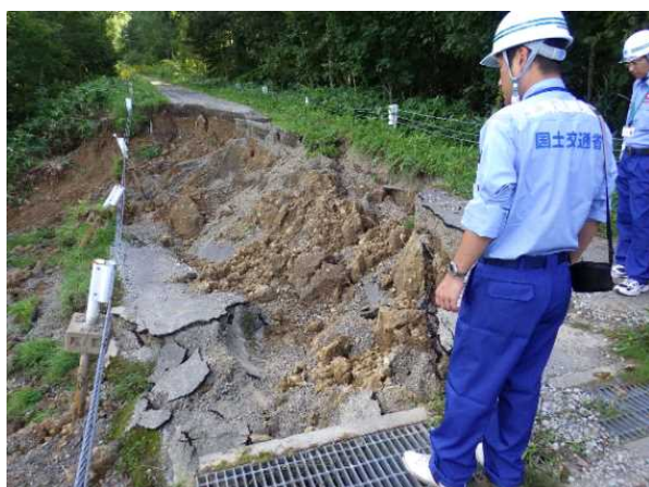
【留萌①】 現地被災状況確認（名寄市）
