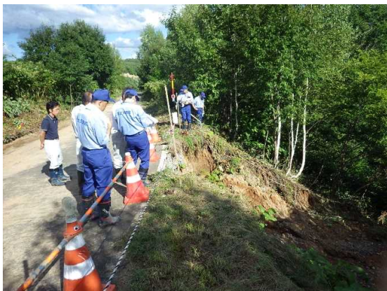
【留萌②】 現地被災状況確認（剣淵町）
