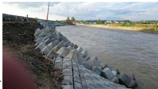
美瑛町北瑛地先の緊急復旧の状況
