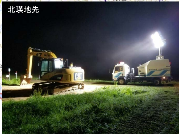
運搬路造成(敷鉄板設置)
