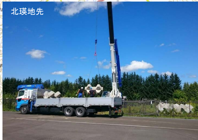
ブロック運搬状況
