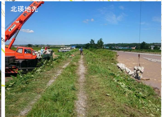
協定業者により投入作業を実施
