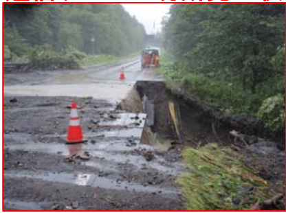
R39 通信ケーブル切断発生状況
