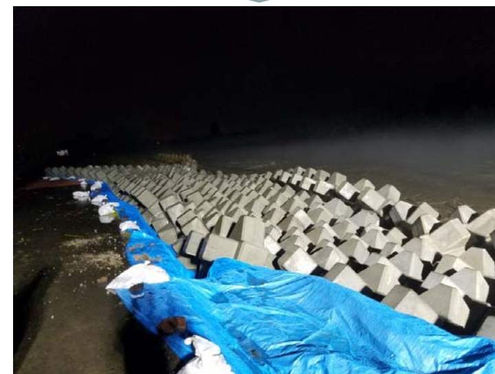
応急復旧完了 (完了 8/23 2:20)
