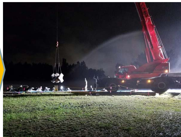
50tクレーンを配置しブロックを投入
