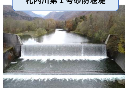
札内川第1号砂防堰堤
