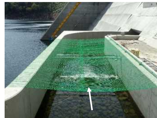
遡上解析ビデオカメラ設置状況
