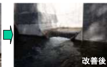
モサンル川 谷止工 魚道下流落差改善
