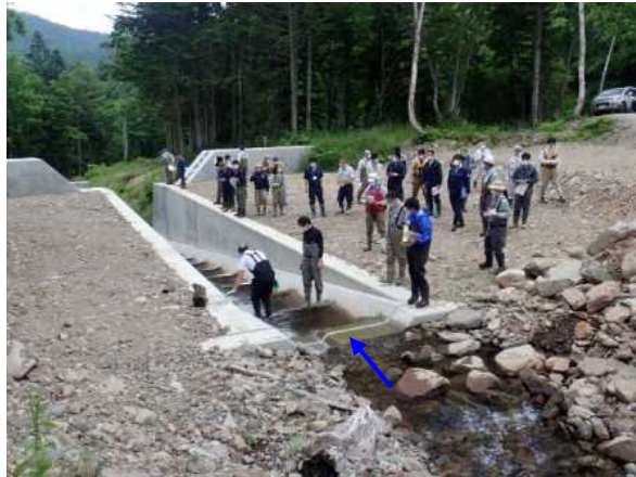
右の沢川 No2床固工 全景(上流側から)
